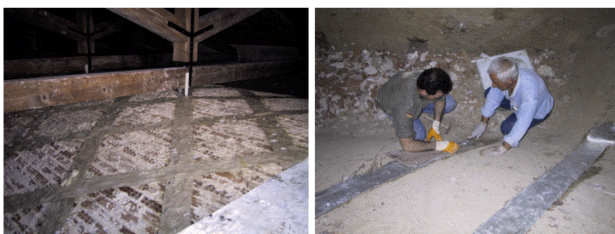
Figura 2: Applicazione delle fasce in fibra di vetro per il consolidamento della volta
