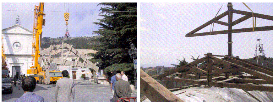
Figura 1: Rimozione delle capriate in c.a. e messa in opera delle nuove capriate in legno
