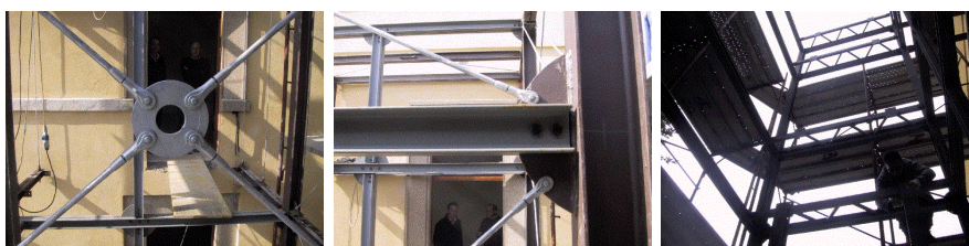
Figura 19: Castello per ascensore in acciaio e vetro: immagini del cantiere
